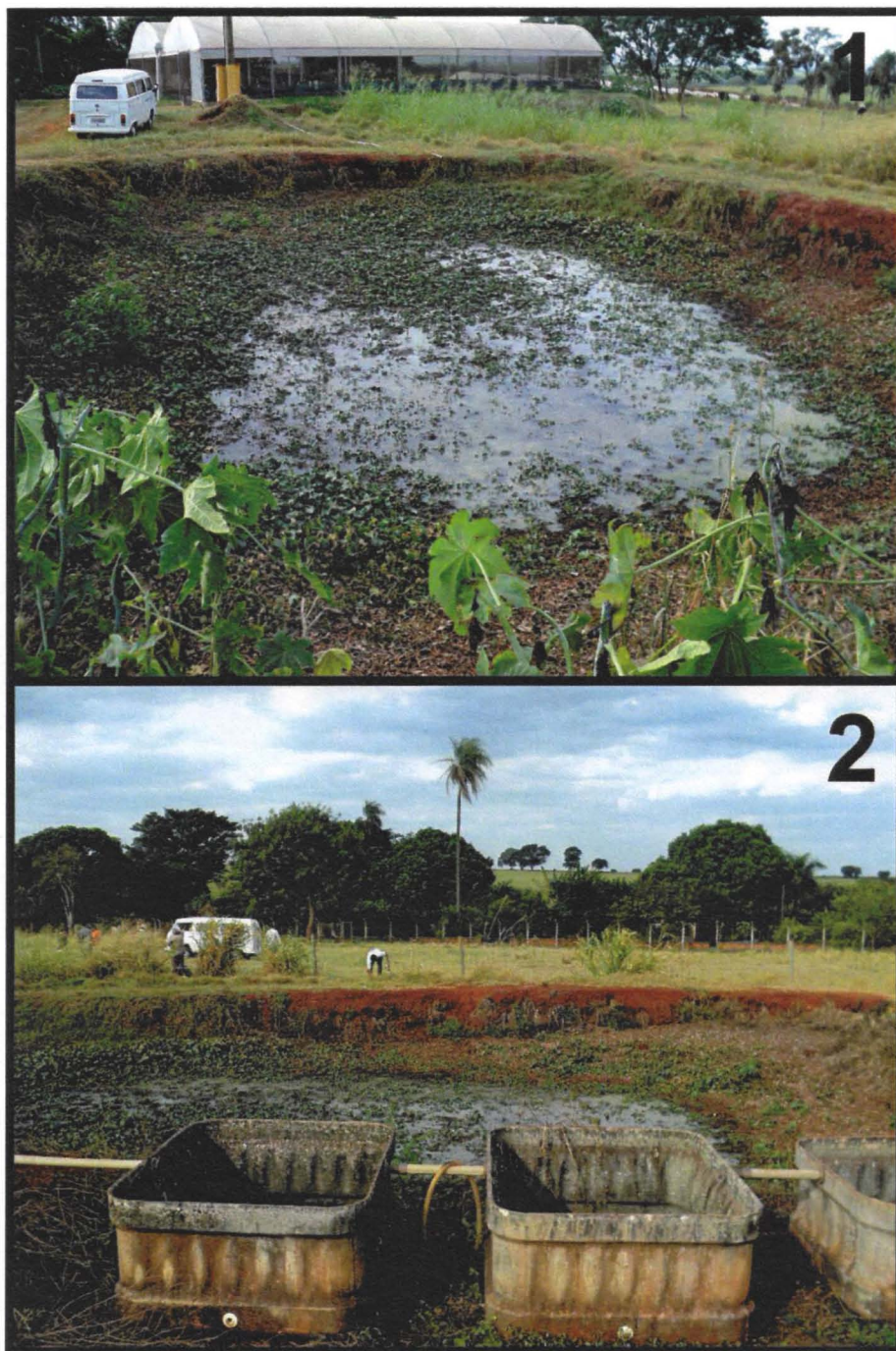
Figura 5.2.1 – 1. Lagoa vista de SW para NE, estufa ao fundo. 2. Lagoa vista de NW para SE, descampado ao fundo (jusante).
